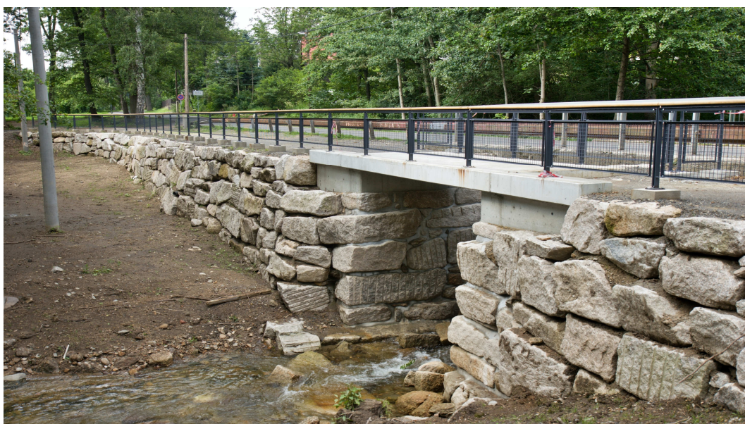
Most u retenční nádrže podél komunikace do Fojtky
