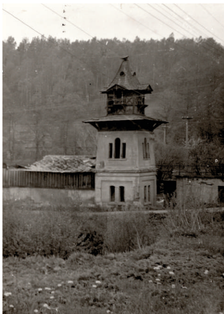
Obrázek č. 2 Na fotografii je holubník v neutěšeném stavu před demolicí, který stával v místě dnešních garáží vedle budovy obecního úřadu. Byl zbourán cca z kraje 80. let 20. století.
