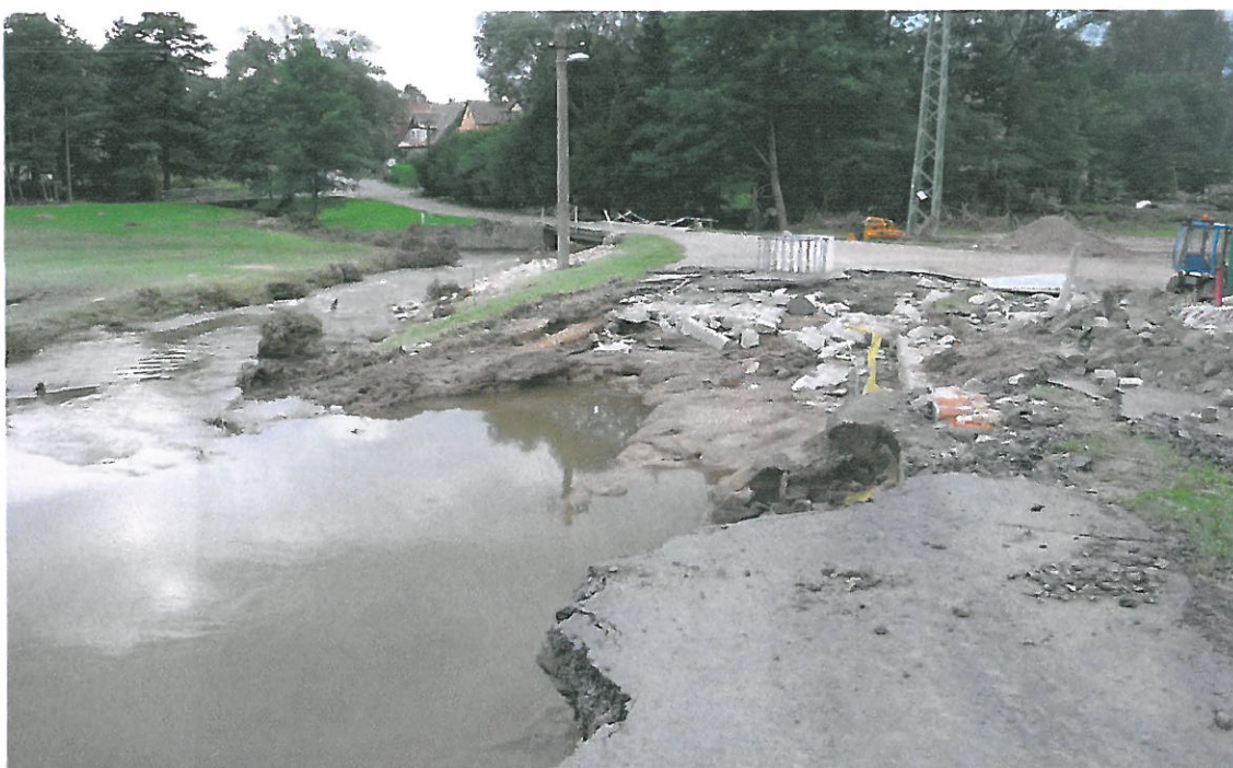
Obr. č. 27 Poškozená komunikace ve Spojovací ul. vedle budovy Obecního úřadu Mníšek
