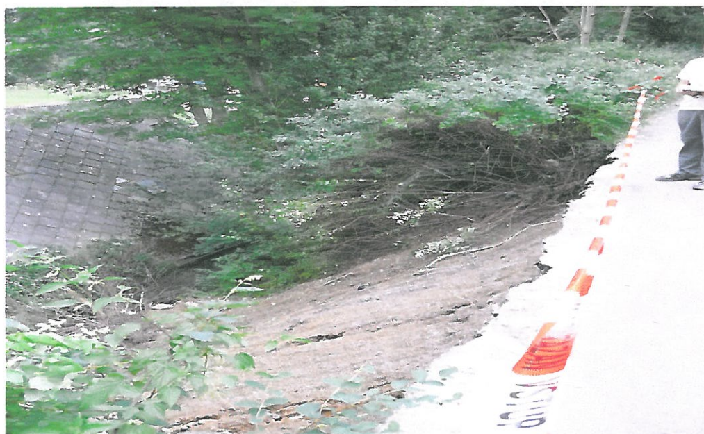
Obr. č. 30 Stejný objekt – pohled shora
