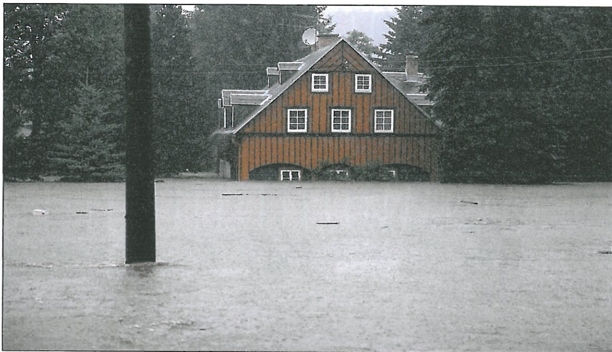
Obr č. 15 Zaplavená část obce Mníšek směrem na N. Ves při kulminaci 2. povodňové vlny – dům č. e. 46
