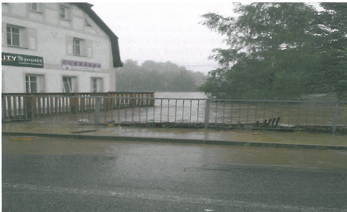
Obr č. 6 Zaplavený most u čp. 176 – zábradlí bylo později kvůli naplavenému materiálu odstraněno
