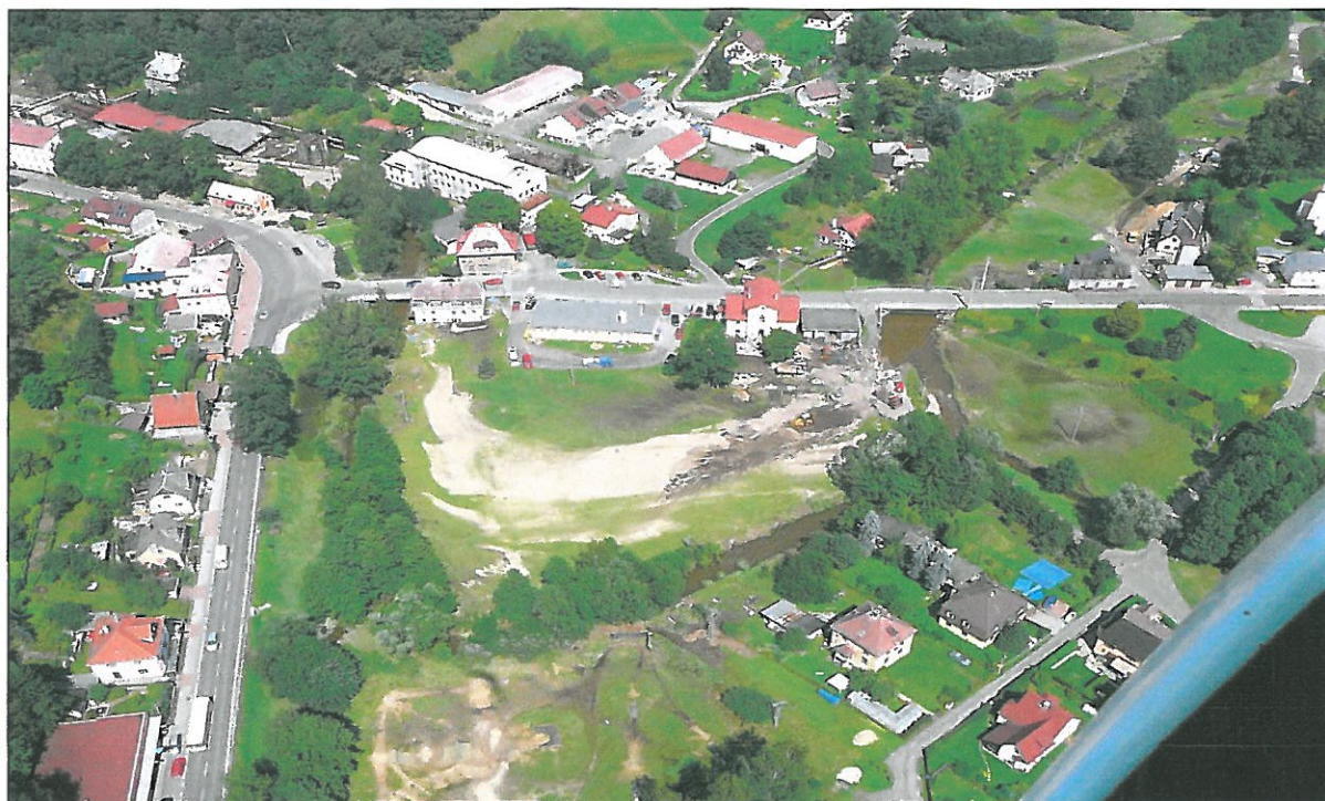
Obr č. 33 Situace po opadnutí vody v okolí budovy Obecního úřadu v Mníšku
