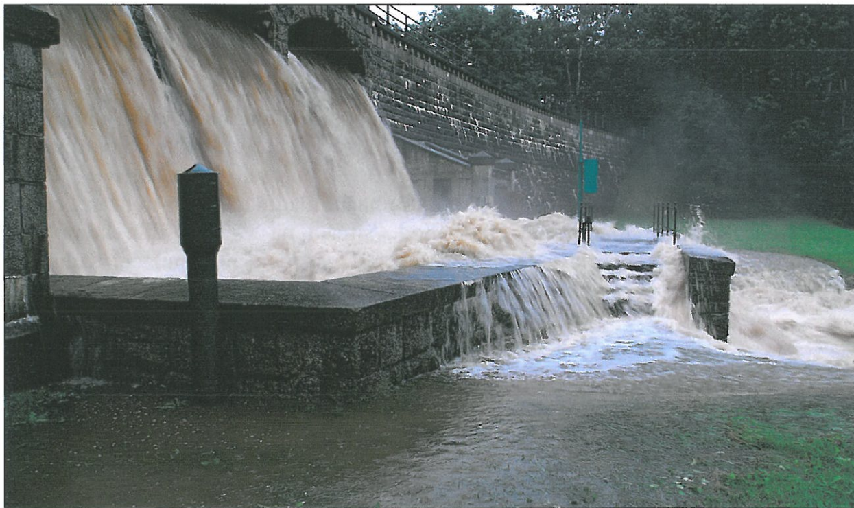
Obr. č. 8 Mníšecká přehrada v průběhu povodně dne 7. 8. 2010
