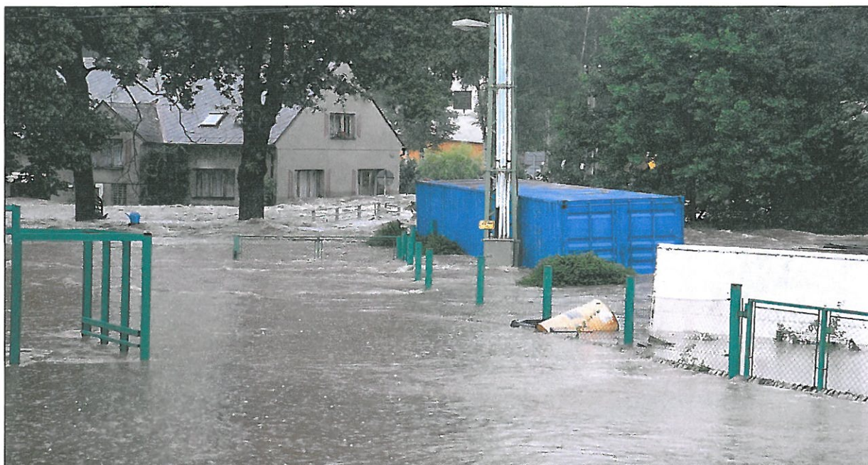
Obr. č. 17 Zaplavená část obce Mníšek směrem na N. Ves při kulminaci 2. povodňové vlny dům čp. 206
