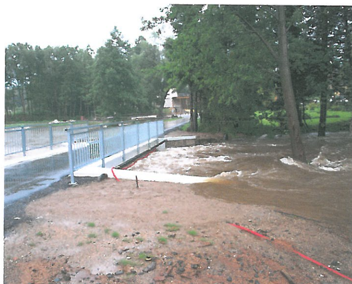
Most pod OÚ-Spojovací ul.
